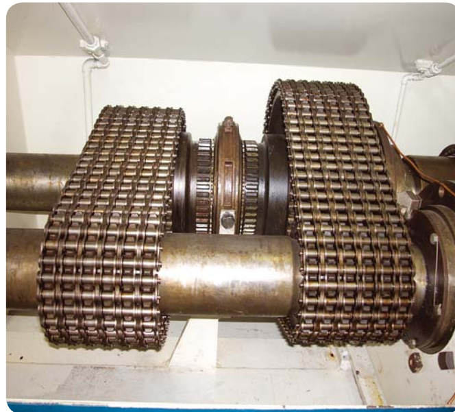
Řetězy SKF s více řadami pro ropný průmysl použité v kalovém čerpadle
